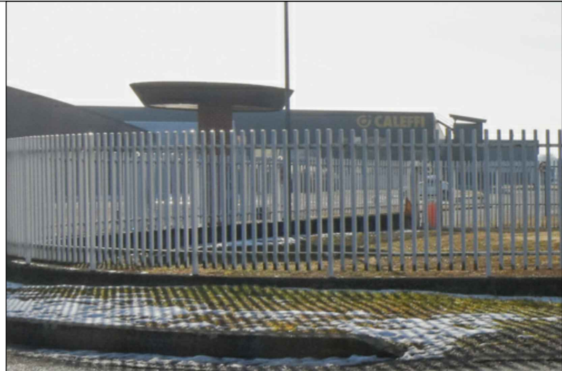
Recinzione esistente mantenuta
