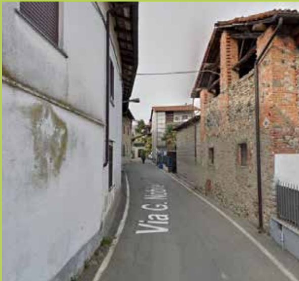
Stato di fatto. Via Nobile (in arrivo dal parcheggio pubblico)
