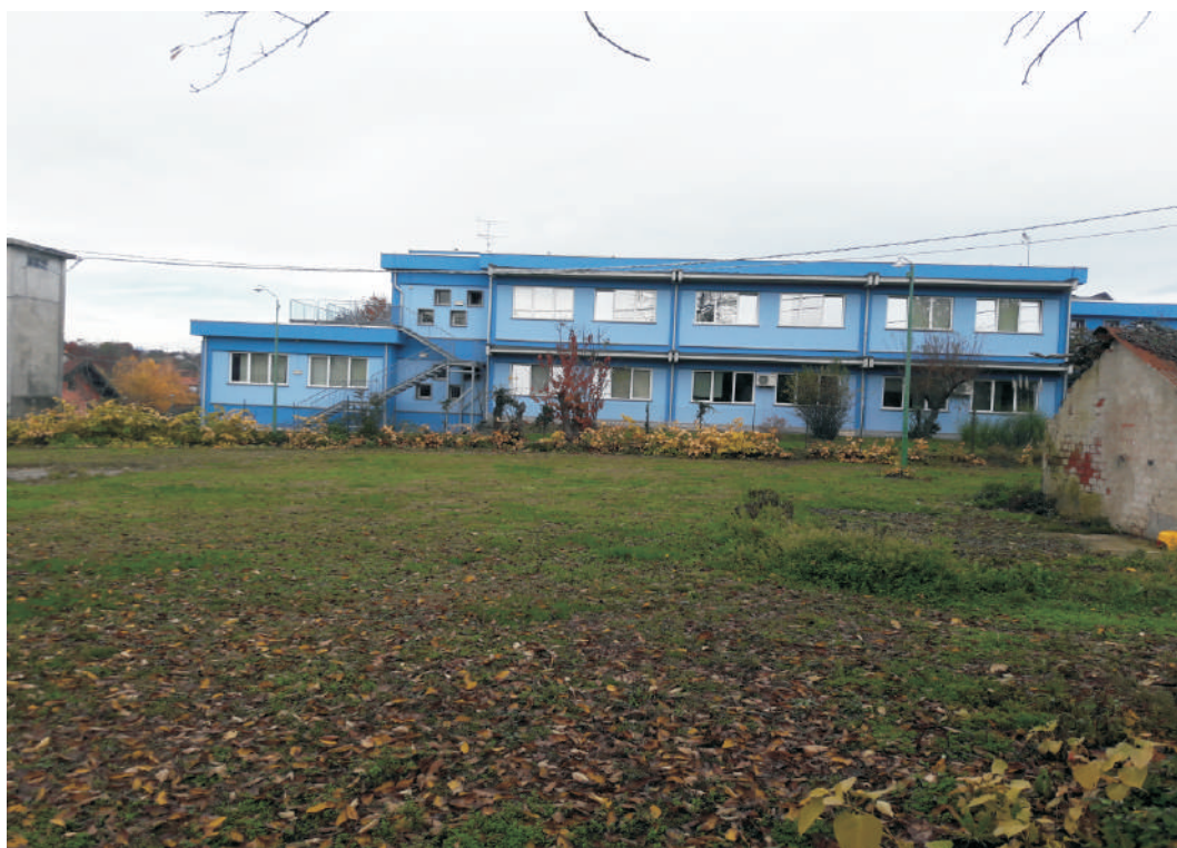
Situazione morfologica verso il complesso scolastico confinante. Nessuna problematica evidenziata.
