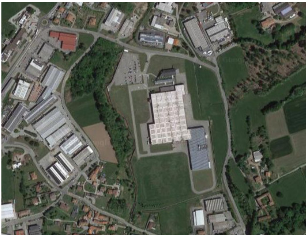
Foto zenitale con perimetrazione area PEC- Scheda d'ambito PE.1
